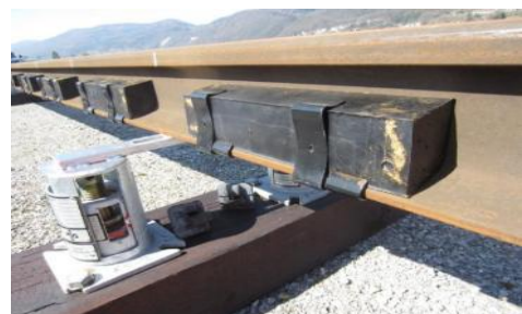
รูปที่ 6 การติดตั้งตัวหน่วงรางชนิดโพลียูรีเทน
